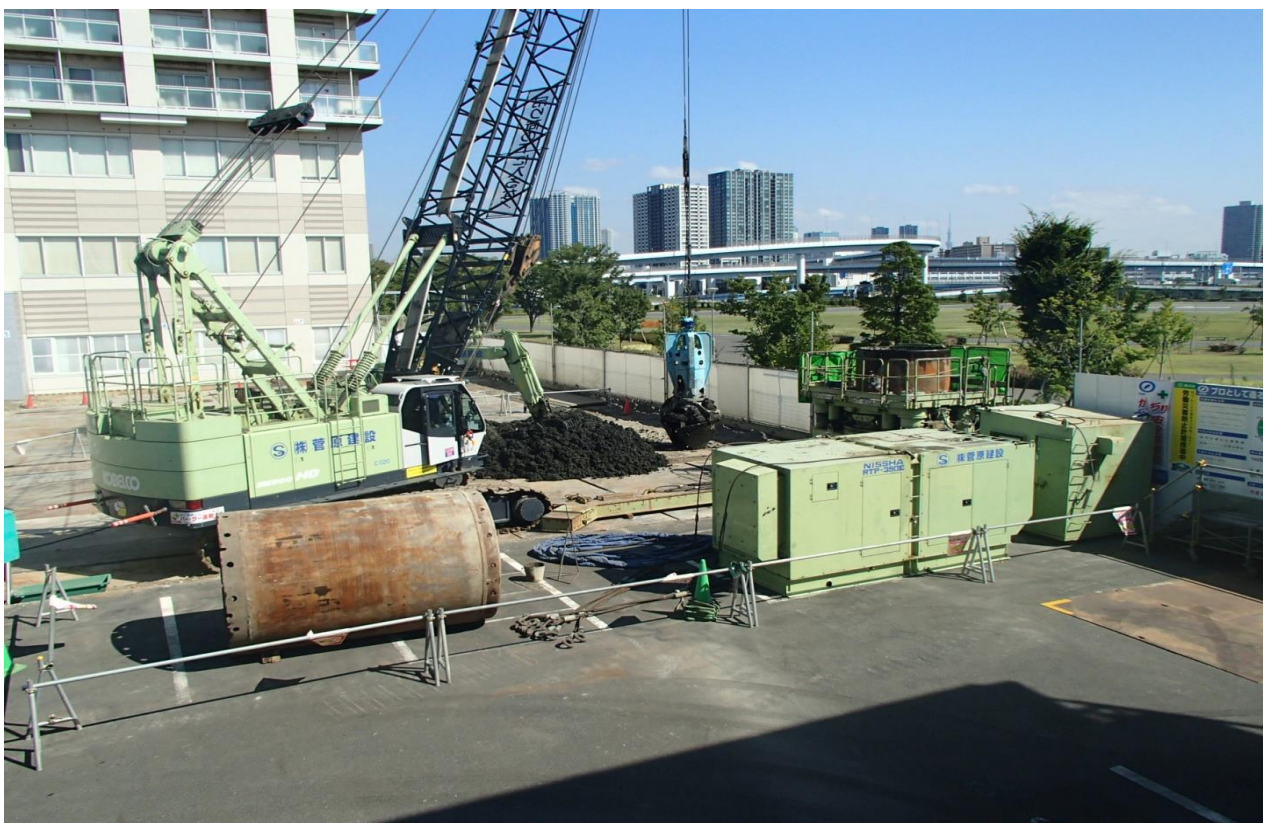
⑧ 工事状況 地中障害撤去工事
