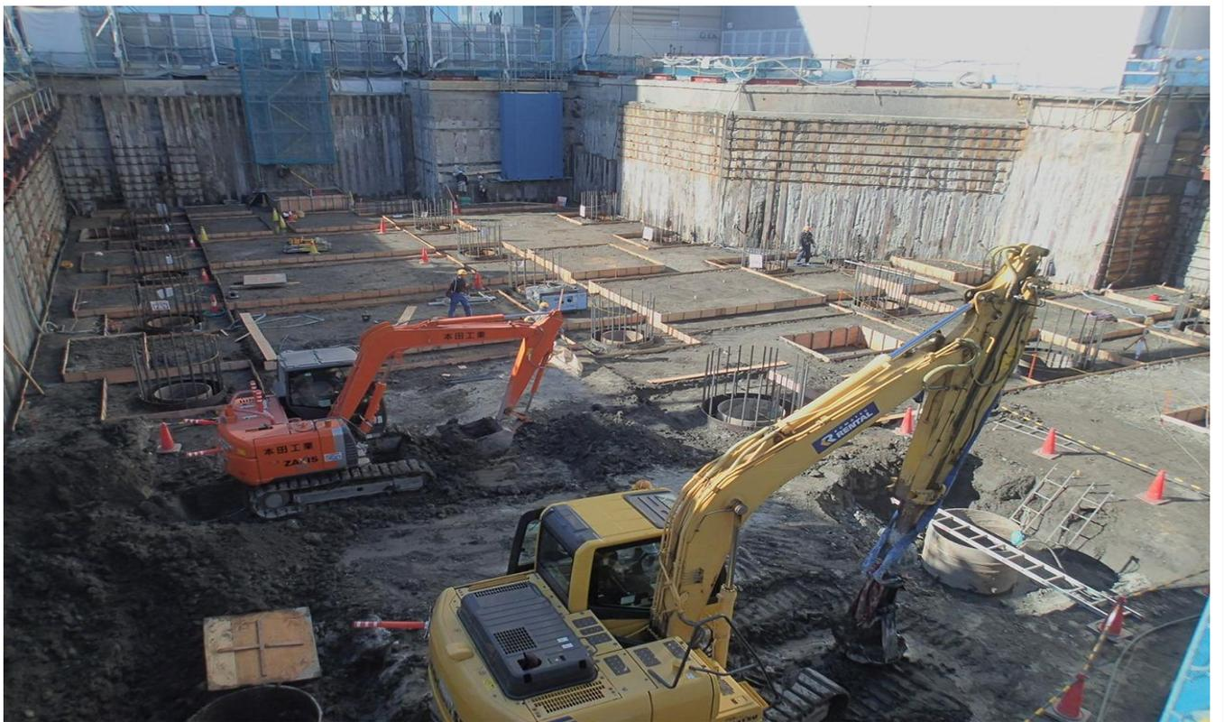
⑤ 根切最終面レベルコンクリート打設状況
