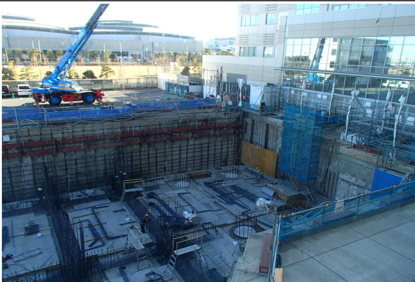
② 耐圧盤1工区 基礎配筋
