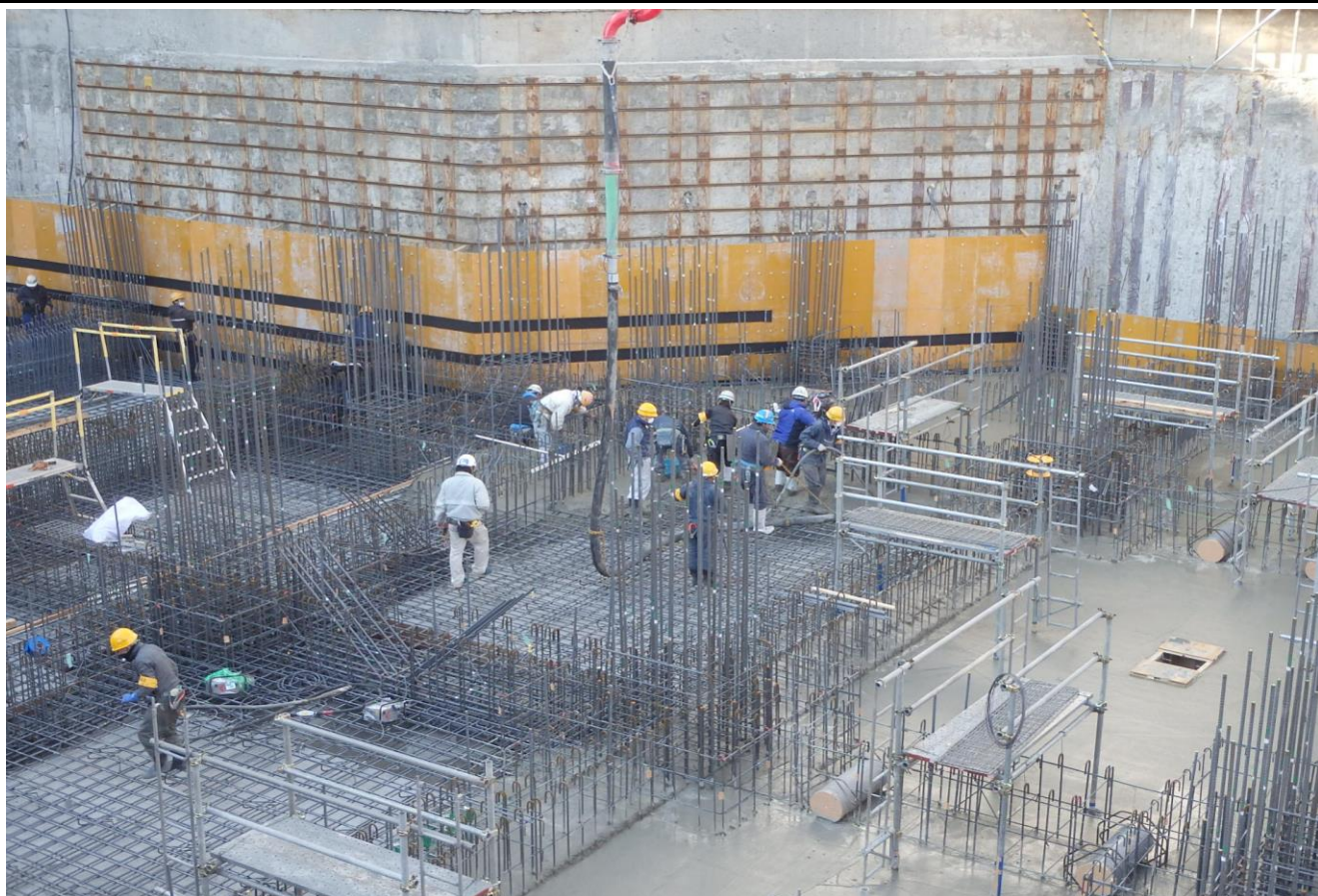
④ 耐圧盤2工区 マットスラブ下 コンクリート打設
