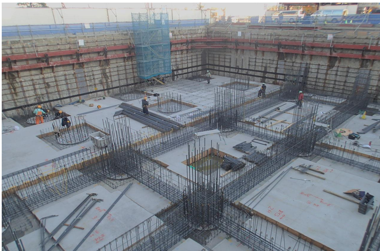
② 耐圧盤1工区 基礎配筋
