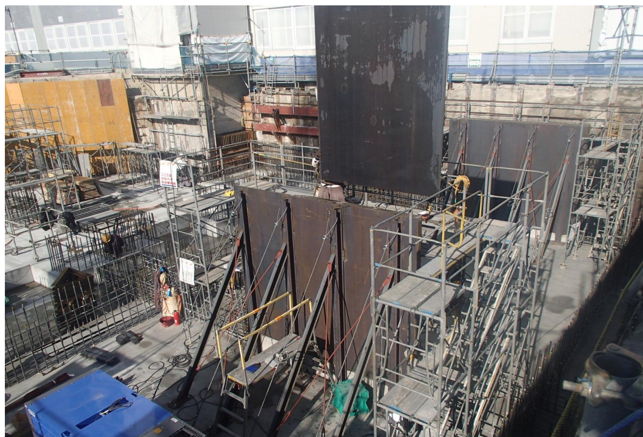
④ リニアック室5 壁遮蔽鉄板取付
