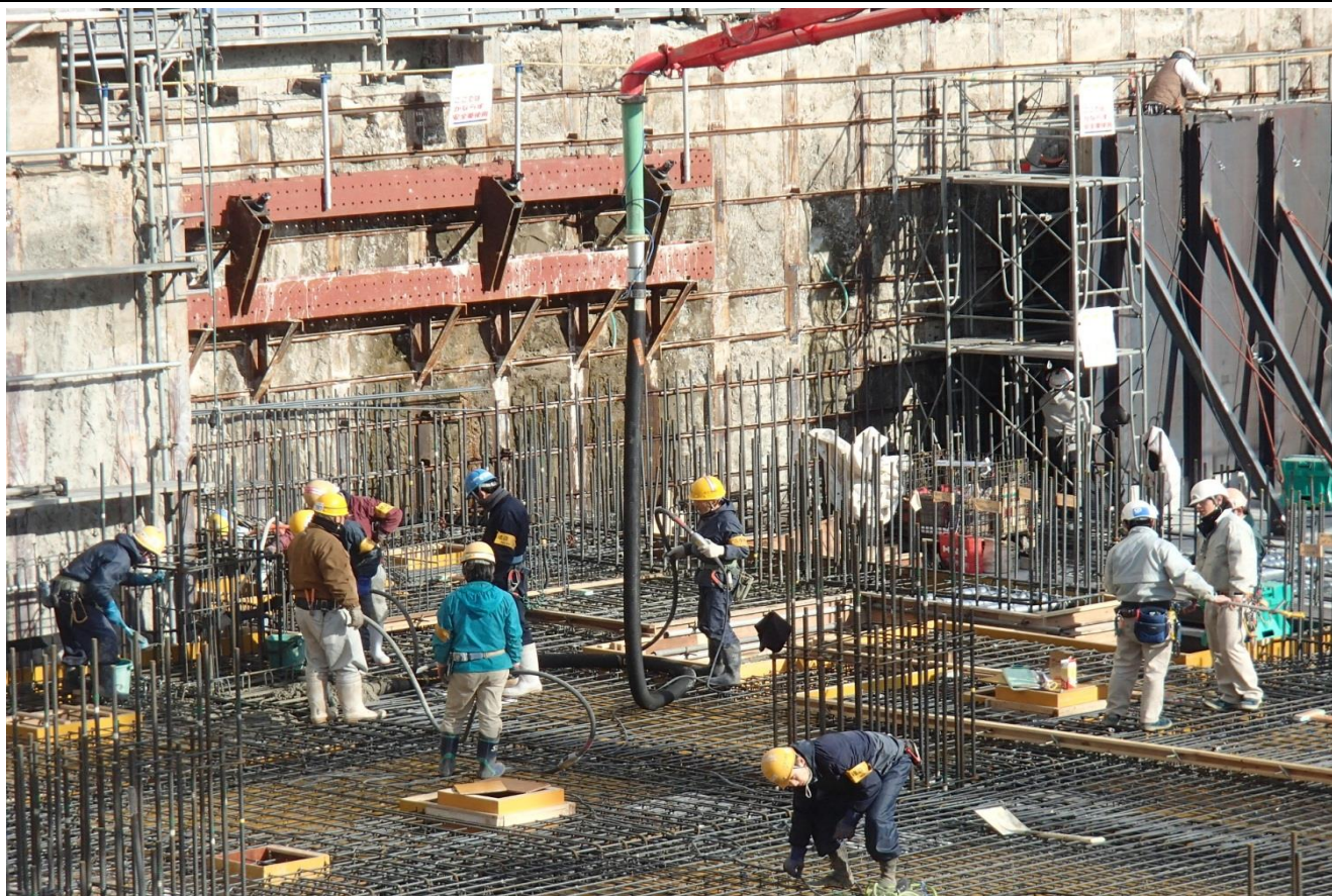
③ B1階 1工区 基礎立ち上がりコンクリート打設
