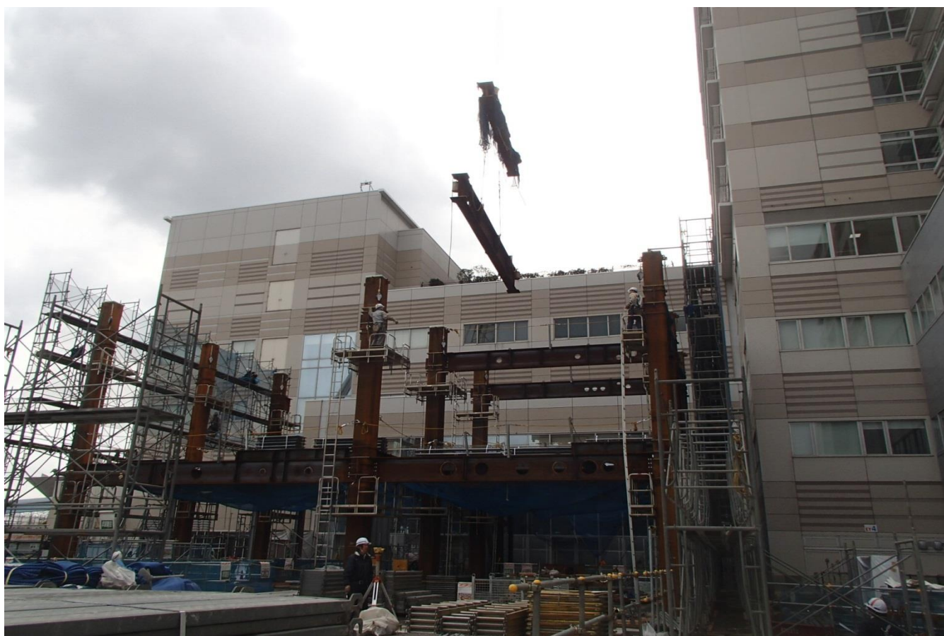
④ 1節鉄骨建方状況(3階梁取付)
