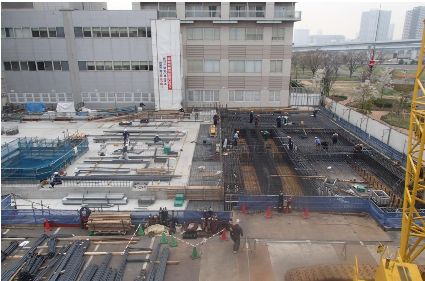
② 1階 2工区リニアック部 床 コンクリート打設
