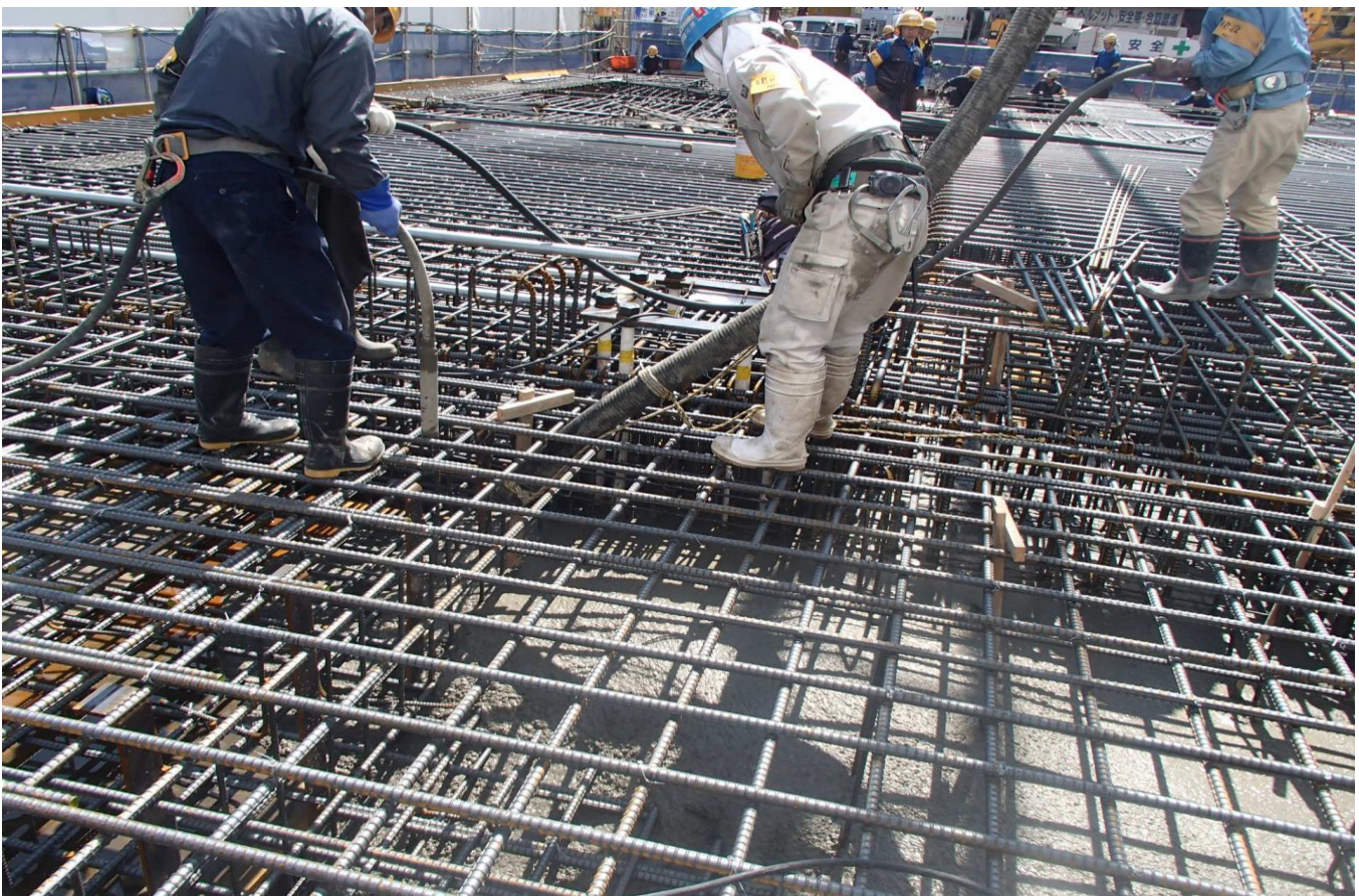
② 1階 2工区リニアック部 床 コンクリート打設
